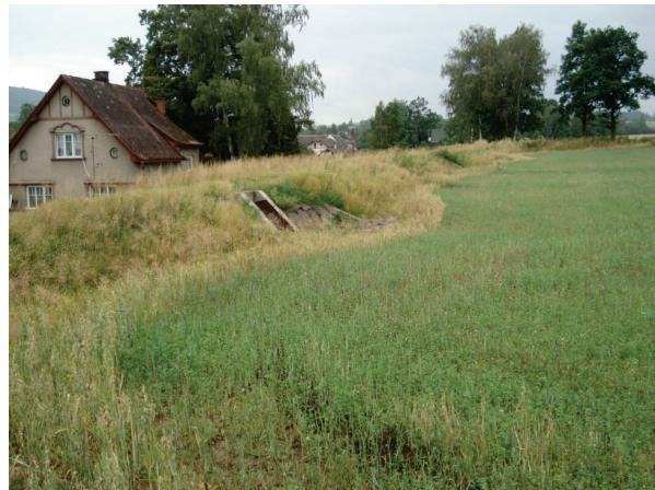
Obr. 6.16. Výpustné zařízení s česlovou stěnou, která zamezuje zanesení a zahlcení potrubí
