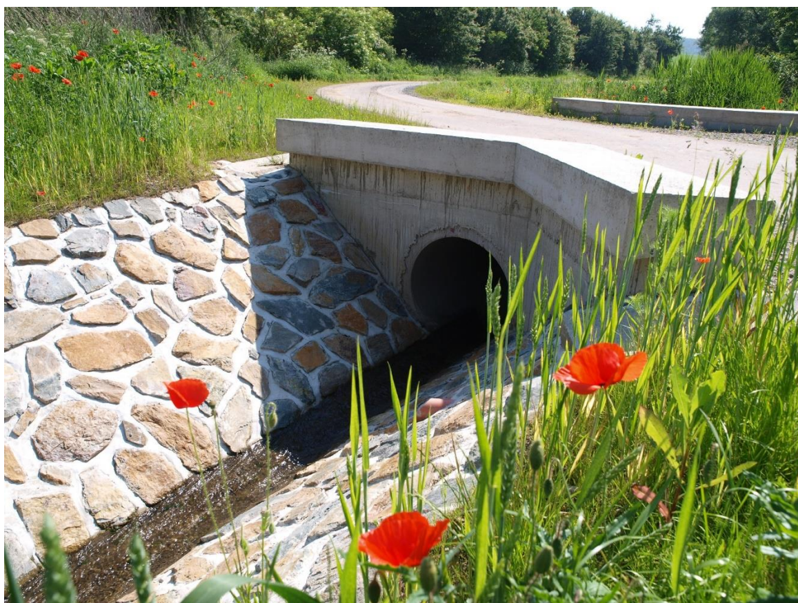
KPÚ pro Jihomoravský kraj - Pobočka Brno, propustek pod hlavní polní cestou C5, k.ú. Malhostovice
