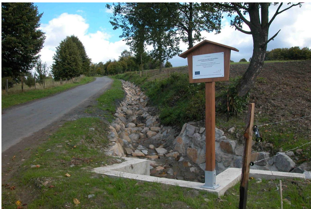
KPÚ pro Zlínský kraj – Pobočka Vsetín, Zpevněná cesta s příkopem H1 v k. ú. Růžďka – po realizaci
